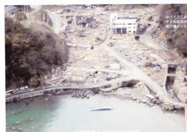
↑津波で壊滅的な被害を受けた大指
